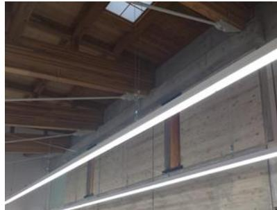
業務室壁面(杉板本実型枠によりコンクリートを木目調に仕上げ、上部に北山杉の磨き丸太(2本)をオブジェとして配置)
